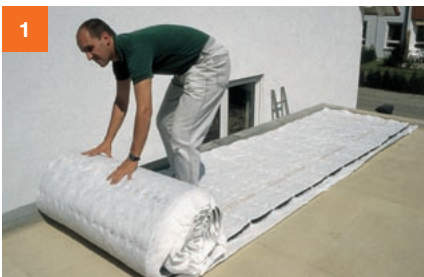
SDF-Matte auf der wurzelfesten Abdichtung ausrollen ...
