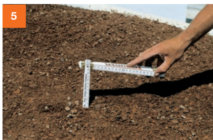
Auf eine gleichmäßige Einbauhöhe der Pflanzerde von ca. 8 cm achten.
