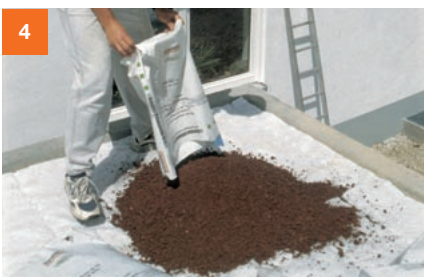
Unmittelbar im Anschluss pro Quadratmeter zwei Sack Pflanzerde einbauen. Bauder SDF-Matte nicht ohne Auflast liegen lassen.
