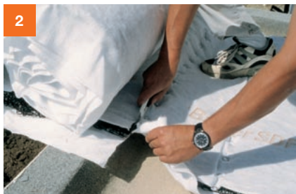
... zurechtschneiden und vollflächig, stumpf gestoßen verlegen. Überlappung der Längsnähte schließen.
