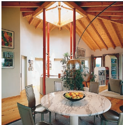
Profilholzschalung und -sparren naturbelassen
